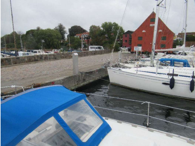
Kajstrækning øst indre - Oversigtsbillede
