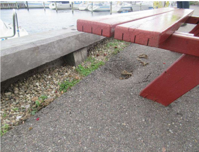
Kajstrækning syd indre - Kajvæg
