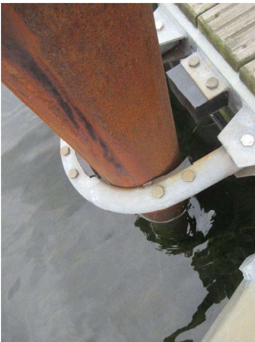
Bro 10 - Pælestyr Kraftig slidtage på kunststofklodser på den inderste del af broen.
