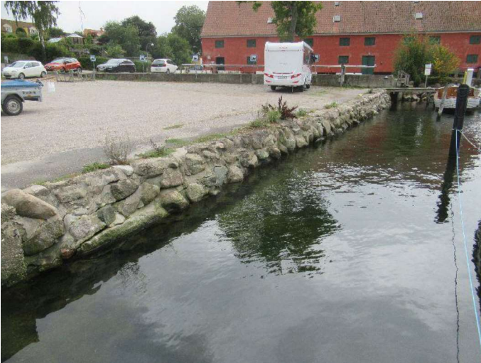
Kajstrækning øst ydre - Oversigtsbillede
