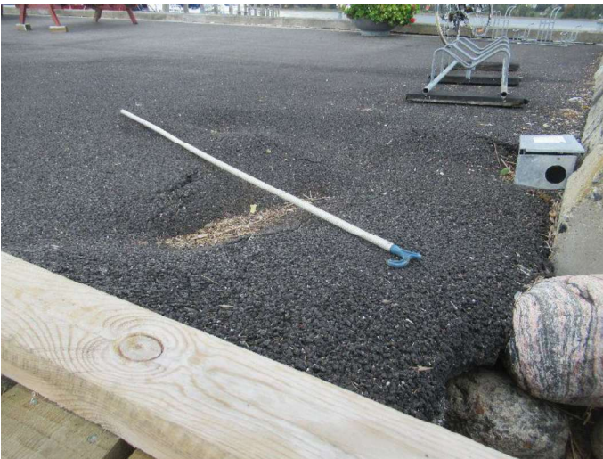
Kajstrækning vest ydre - Kajvæg
