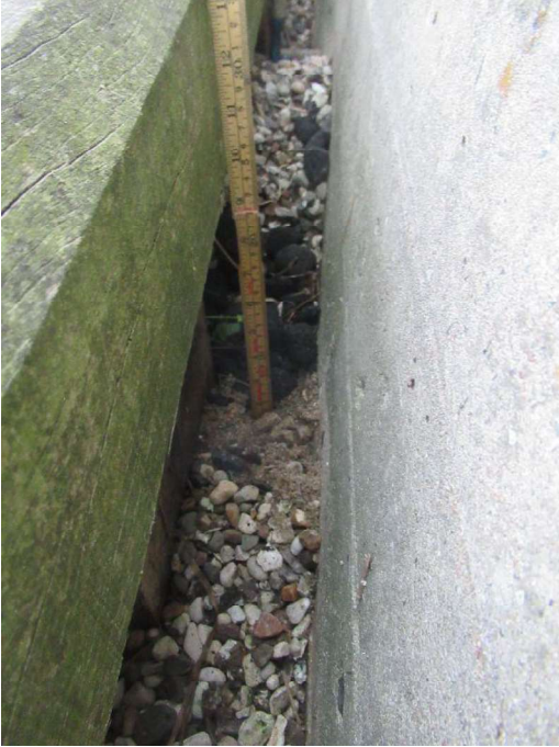
Kajstrækning vest ydre - Kajvæg
