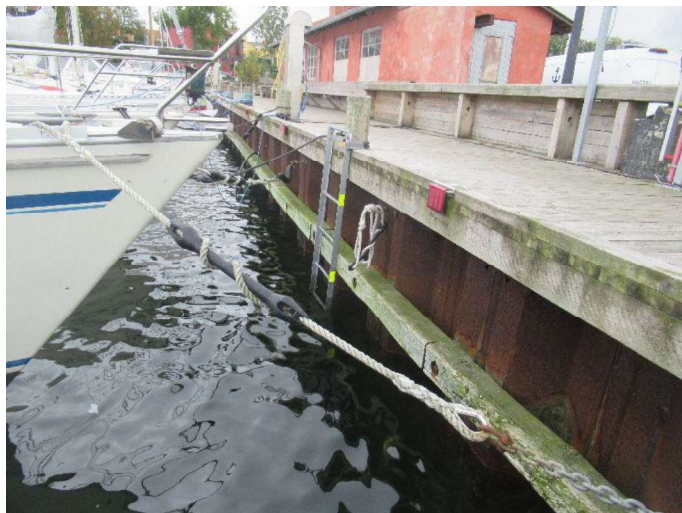
Kajstrækning øst indre - Oversigtsbillede 3
