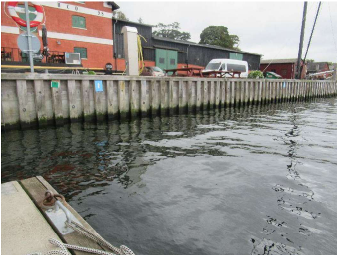
Kajstrækning syd indre - Oversigtsbillede 1
