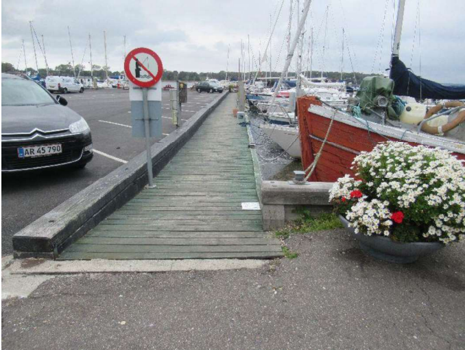
Kajstrækning vest indre - Oversigtsfoto
