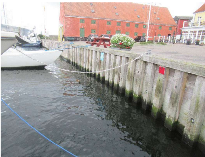
Kajstrækning syd indre - Oversigtsbillede 2
