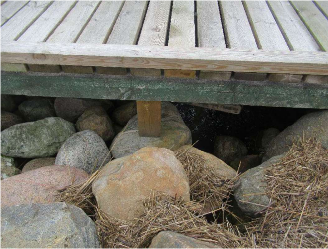
Bro 4 - Understøtning på stenkastning
