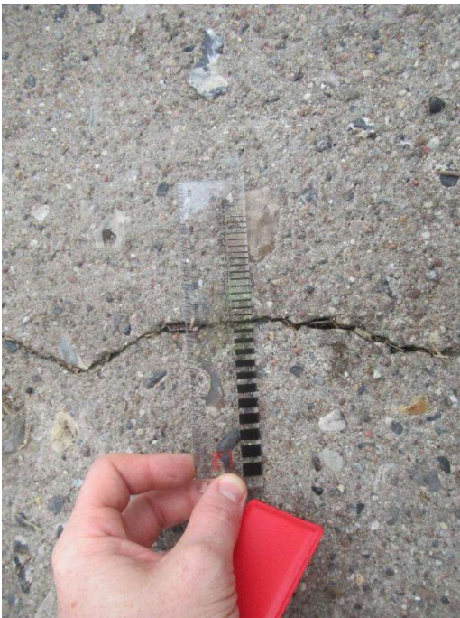
Slæbested øst - Belægning Tykkelse af revne i belægning. Varierer fra ca. 1.5-3.5mm.
