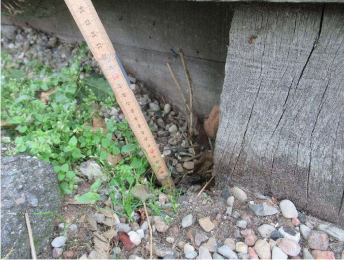
Kajstrækning syd indre - Kajvæg
