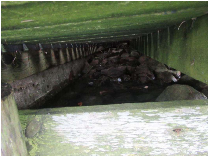
Bro 7 - Bjælker Underside af broens faste del.
