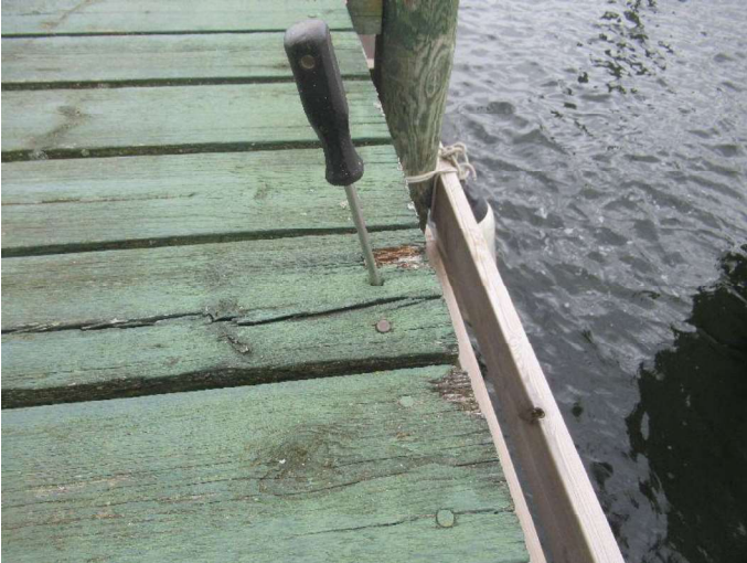
Kajstrækning øst indre - Bådebro Råd i enden af flere brædder i brodækket.
