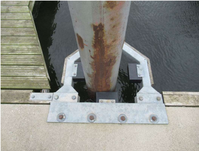
Bro 10 - Pælestyr Yderste pælestyr med let slid på kunststofklodser
