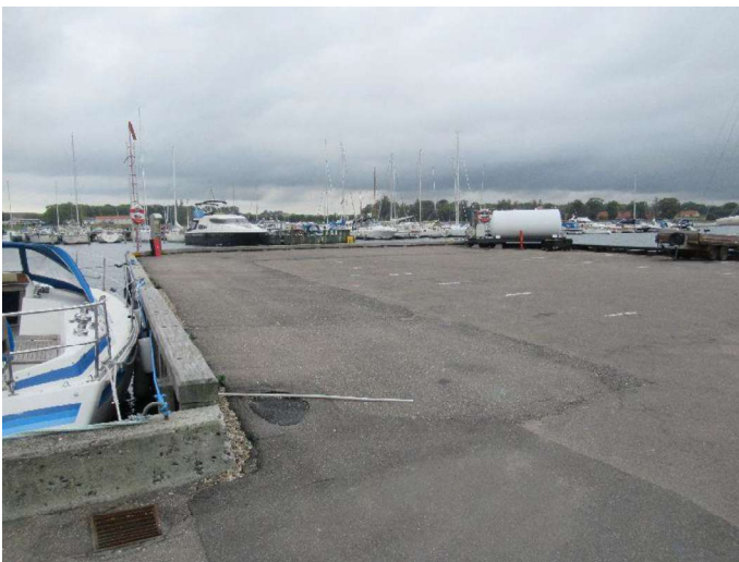
Kajstrækning øst indre - Oversigtsbillede 2
