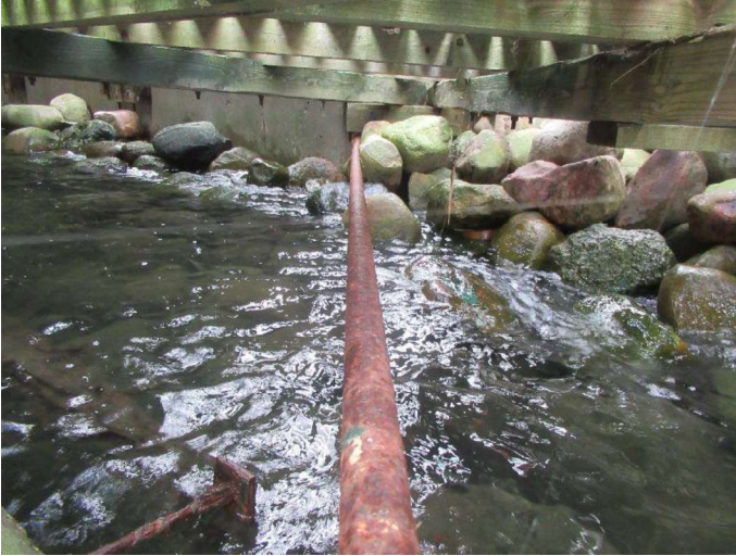
Bro 4 - Fastholdelsesankre Fastholdelses ankre under broen.
