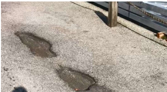
Kajstrækning øst - Belægning
