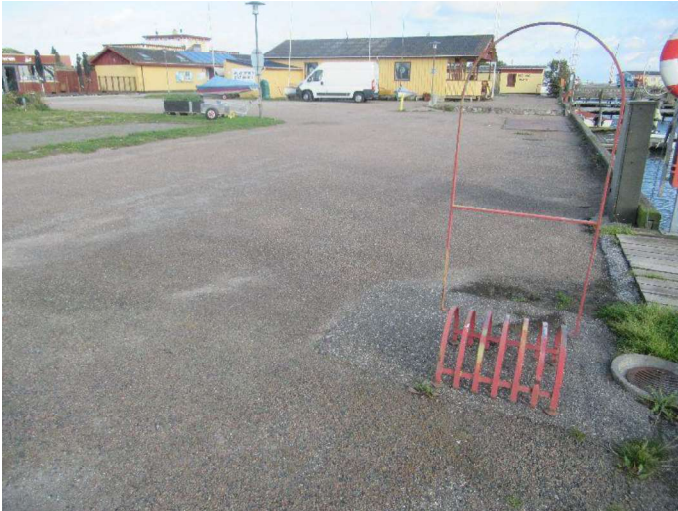
Kajstrækning nord - Belægning oversigtsbillede
