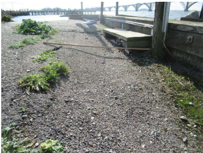
Kajstrækning øst - Kajvæg 1
