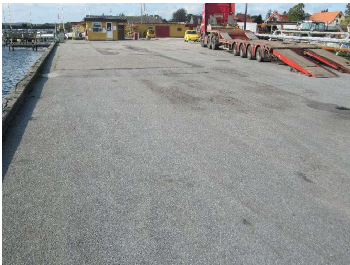
Kajstrækning øst - Belægning
