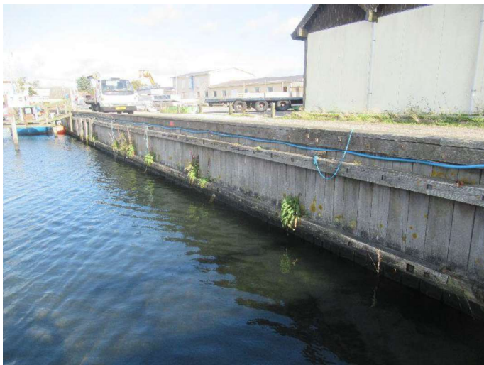
Kajstrækning øst - Oversigtsbillede 1
