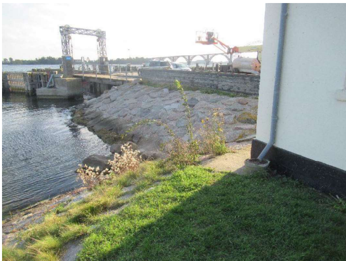
Stenkastning øst Sydligste del af stenkastning med hvad der ligner ny mørtel
