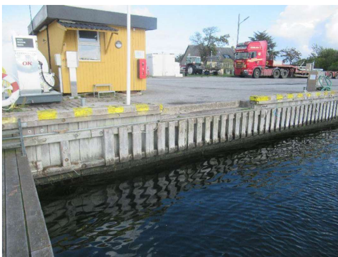
Kajstrækning øst - Oversigtsbillede 3
