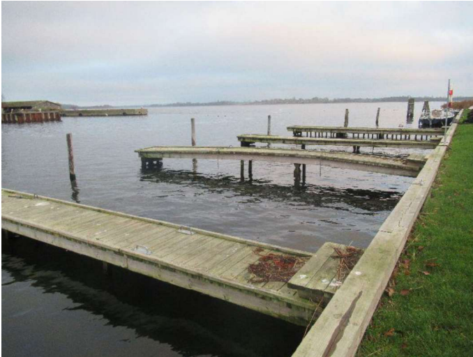
Kajstrækning Fiskerstræde - bådebroer
