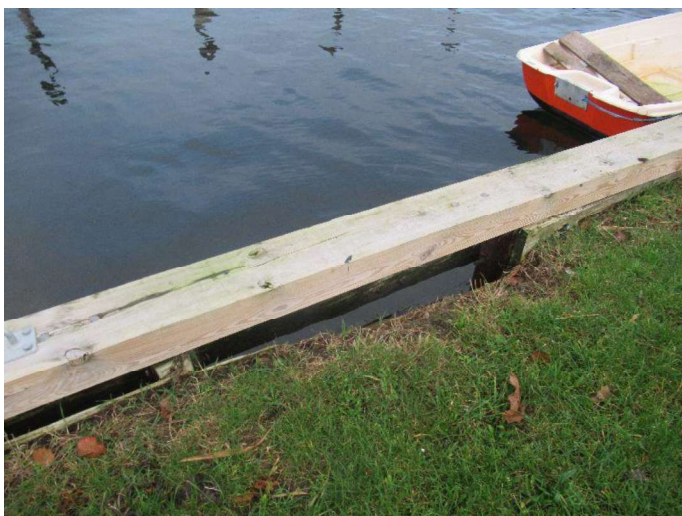
Kajstrækning Fiskerstræde - Kajvæg
