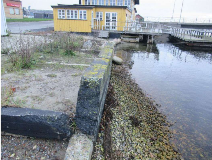
Støttemur ved bro
