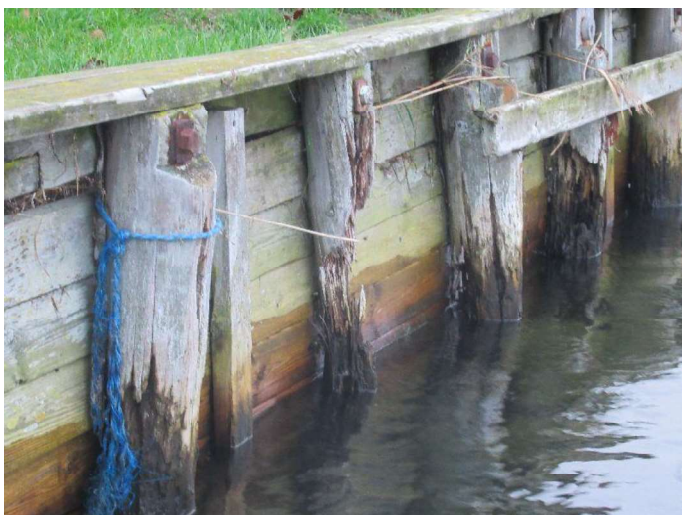
Kajstrækning Fiskerstræde - Kajvæg
