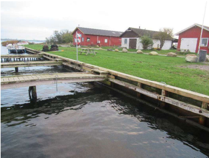
Kajstrækning Fiskerstræde - Bådebroer
