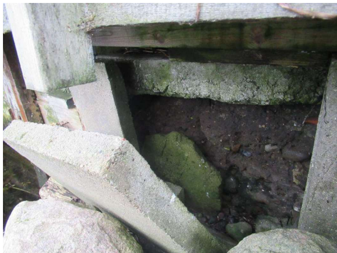
Kajstrækning nord - betonvæg
