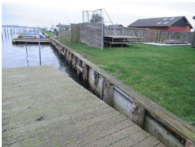
Kajstrækning Fiskerstræde - oversigtsbillede vestlig del
