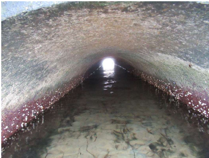
Mole - Afløbskonstruktioner Overflodssikring fremstår i god stand.
