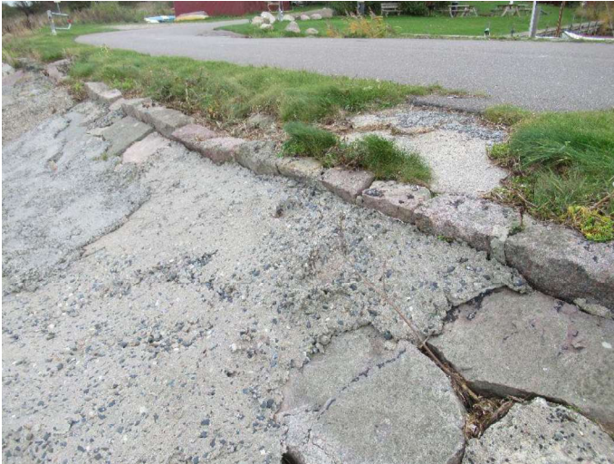
Skråning nord - betonreparationer
