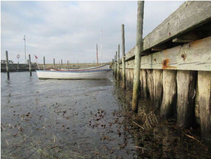
Kajstrækning øst - Kajvæg
