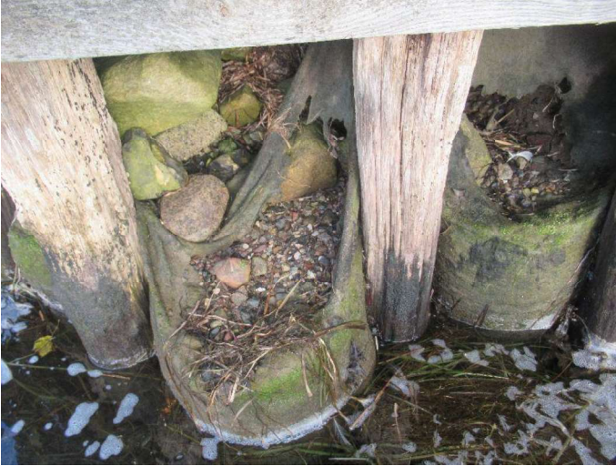
Kajstrækning øst - Kajvæg
