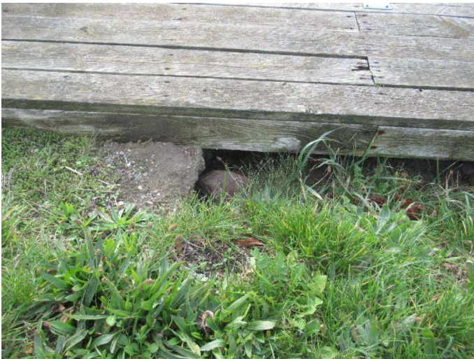
Kajstrækning øst - Kajvæg
