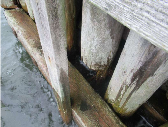
Molehoved - pæle Flere pæle ses med stærkt reduceret tværsnit.
