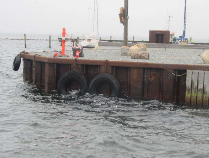
Mole - Oversigtsbillede af yderste del uden fenderbeklædning
