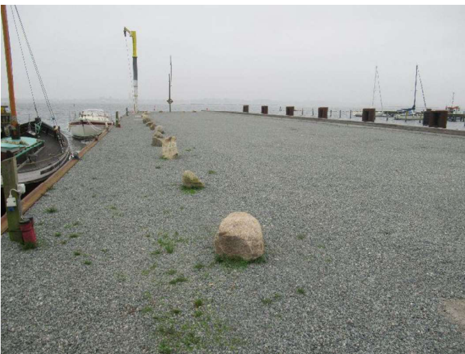
Mole - Oversigtsbillede belægning
