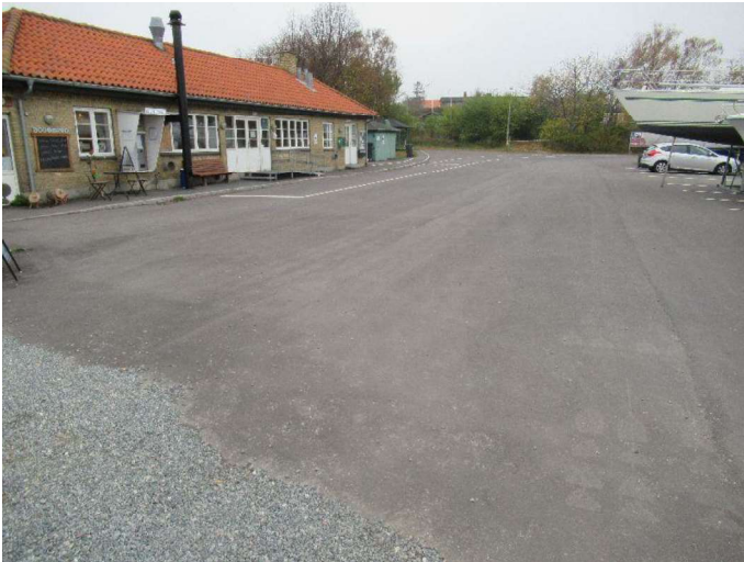
Vej- og parkeringsarealer - Oversigtsbillede hen mod cafe
