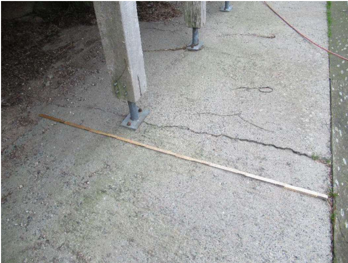
Kajstrækning vest - belægning
