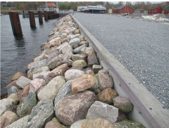
Mole - Oversigtsbillede vestlig betonvæg
