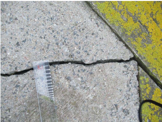
Kajstrækning vest - belægning
