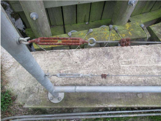
Kajstrækning vest - rækværk
