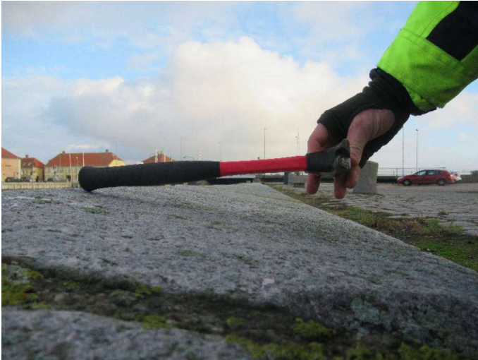
Kajstrækning syd - Hammer
