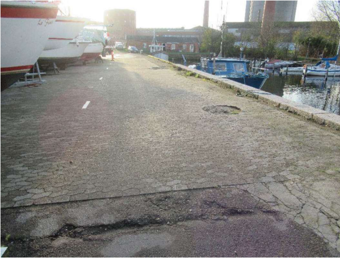
Kajstrækning syd - oversigtsbillede 3
