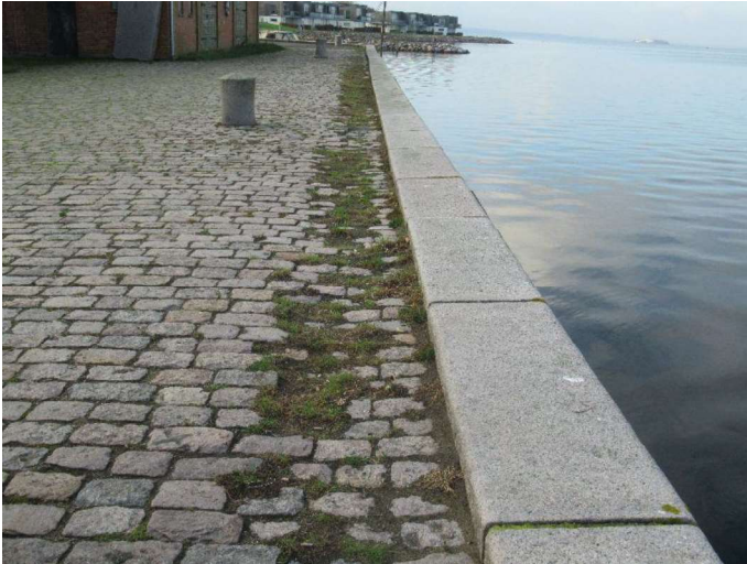
Kajstrækning syd - Kajvæg
