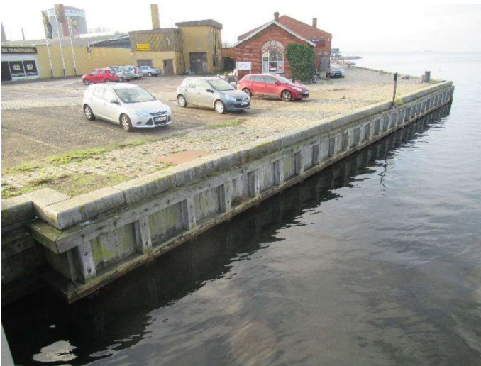
Kajstrækning syd - oversigtsbillede 1
