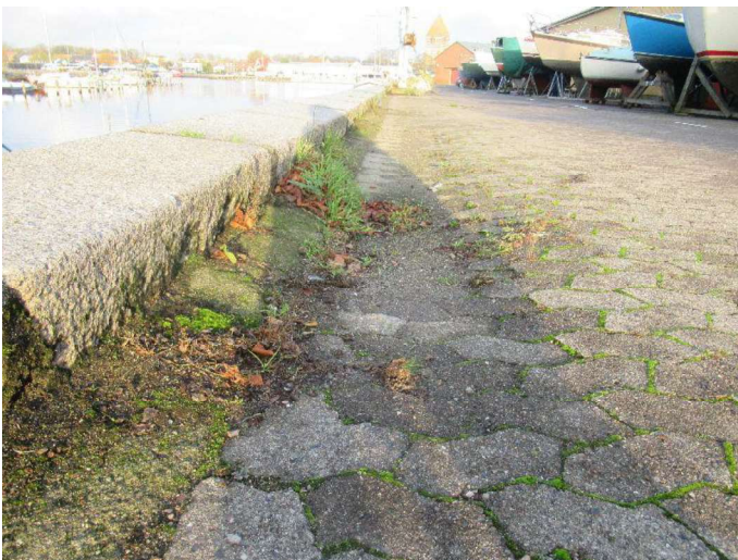
Kajstrækning syd - Kajvæg
