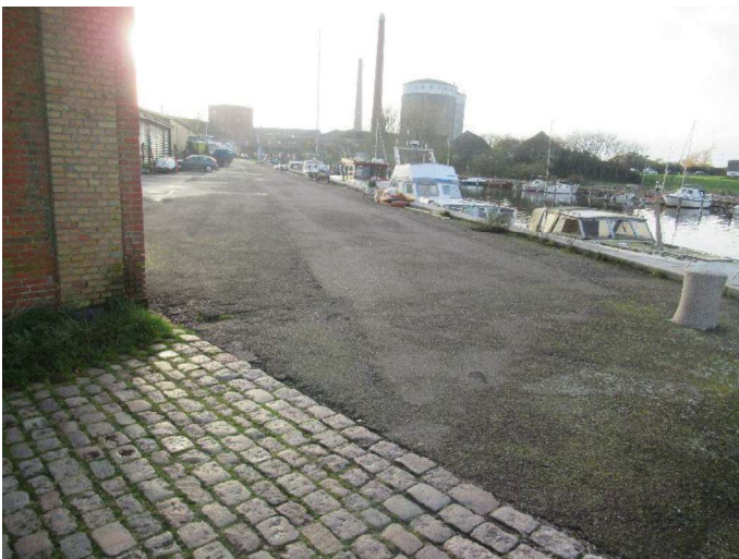
Kajstrækning syd - oversigtsbillede 2
