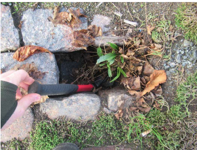
Kajstrækning syd - Kajvæg
