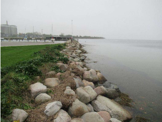
Stenkastning nord - Oversigtsbillede
