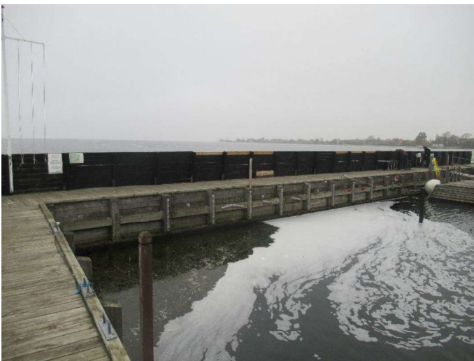
Bro 1 - Kajvæg - Københavnervæg - Oversigtsbillede 2
