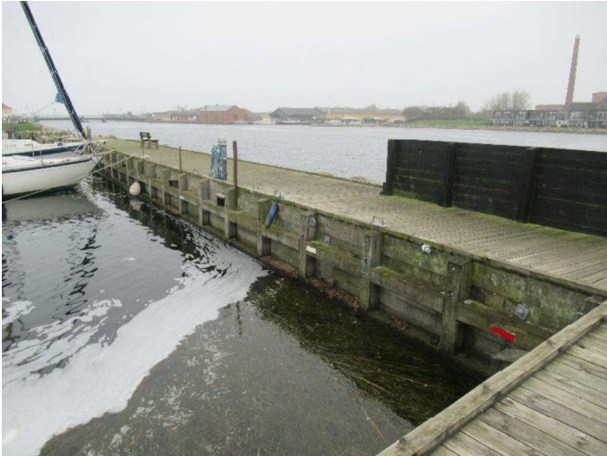
Bro 1 - Kajvæg - Københavnervæg - Oversigtsbillede 1
