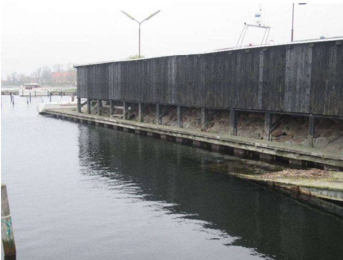
Skråning 3 - Oversigtsfoto ved bro 5
