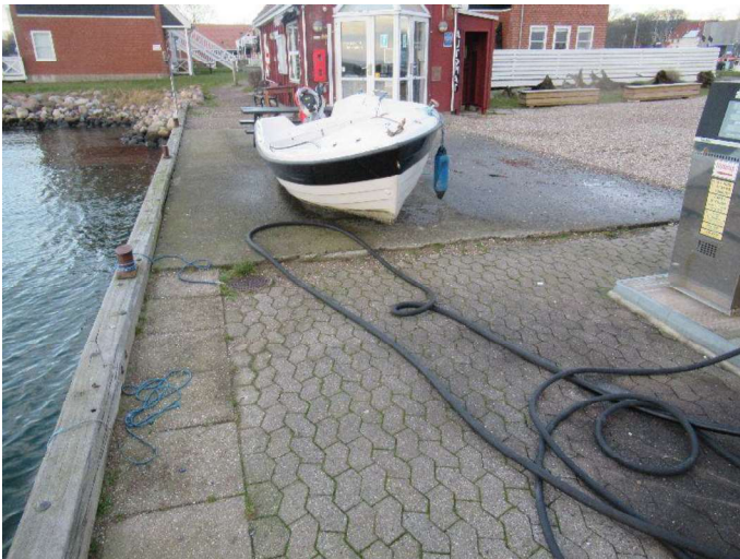
Kajstrækning ved havnekontor - Oversigtsbillede 2
