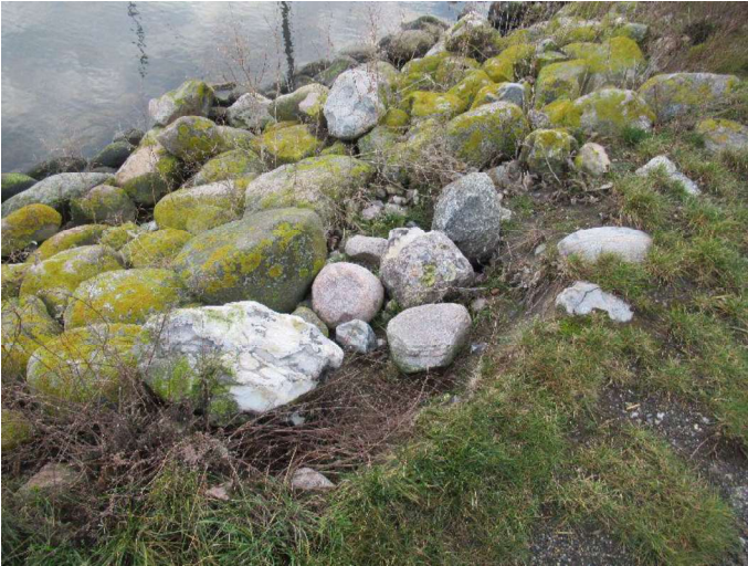
1. skråning - nordlig del 2
