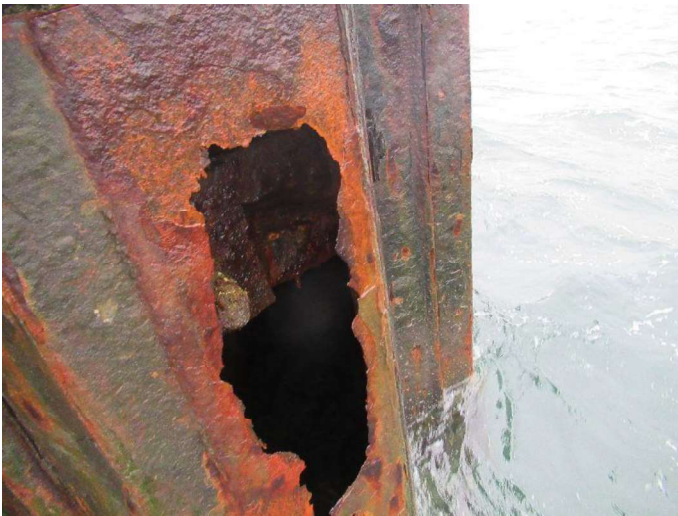
Kajstrækning syd - Kajvæg
