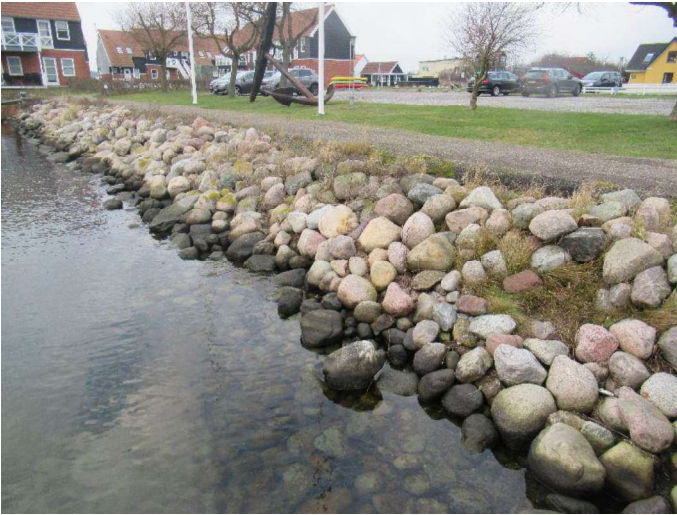
2. skråning - nordlig del
