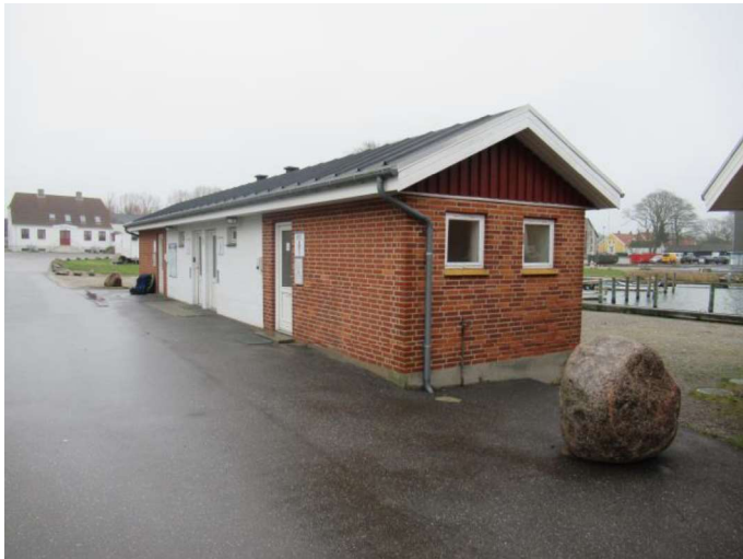
Toiletbygning inderhavn - Oversigtsbillede
