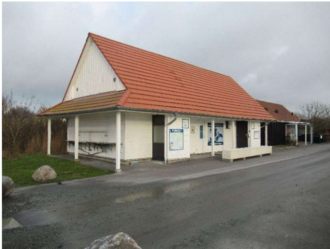
Toiletbygning vest - Oversigtsbillede
