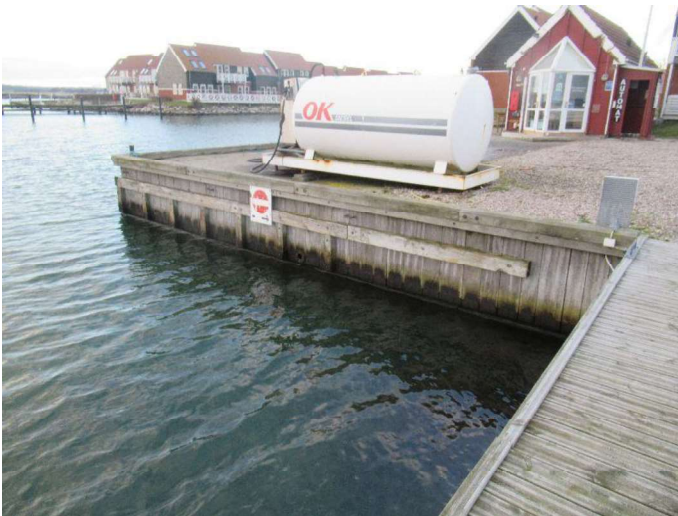
Kajstrækning ved havnekontor - Oversigtsbillede 1
