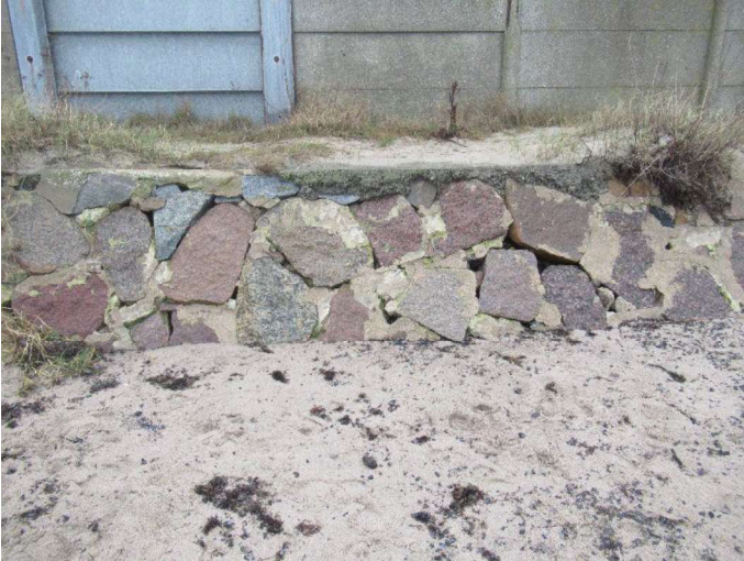
Stenkastning syd - glascisbelagt skråning
