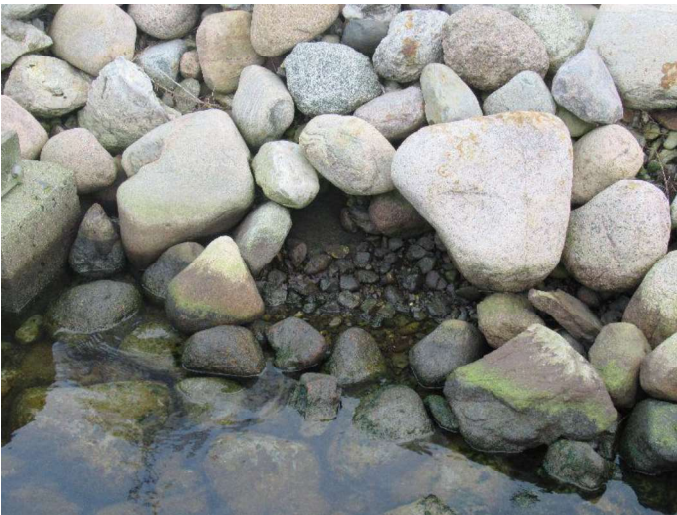
2. skråning - nordlig del
