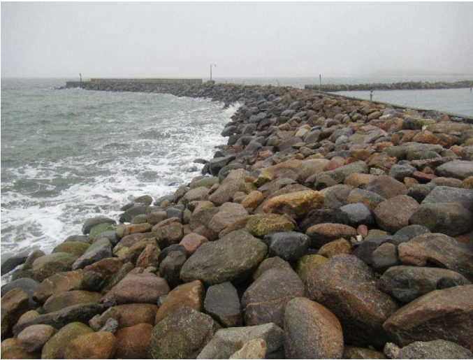
Stenskråning syd - oversigtsbillede
