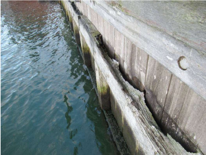
Kajstrækning ved havnekontor - Kajvæg
