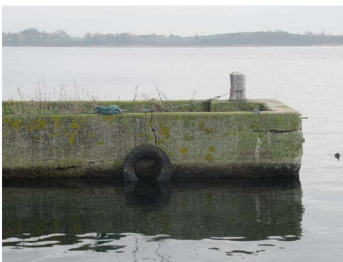
Kaj øst - Kajvæg
