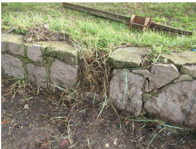
Kaj øst - kajvæg
