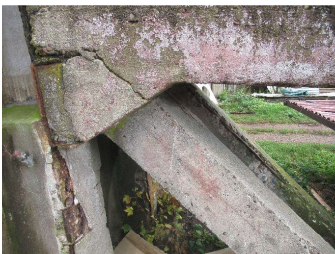
Beddinganlæg - beton modholdet
