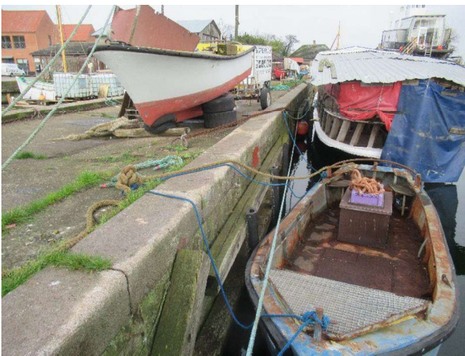
Kaj midt - strækning mod beddinganlæg
