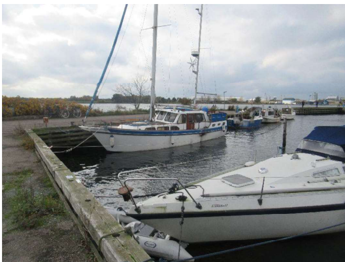
Øst mole - Yderste strækning oversigtsbillede Strækning er omtrentlig øst-vest orienteret.
