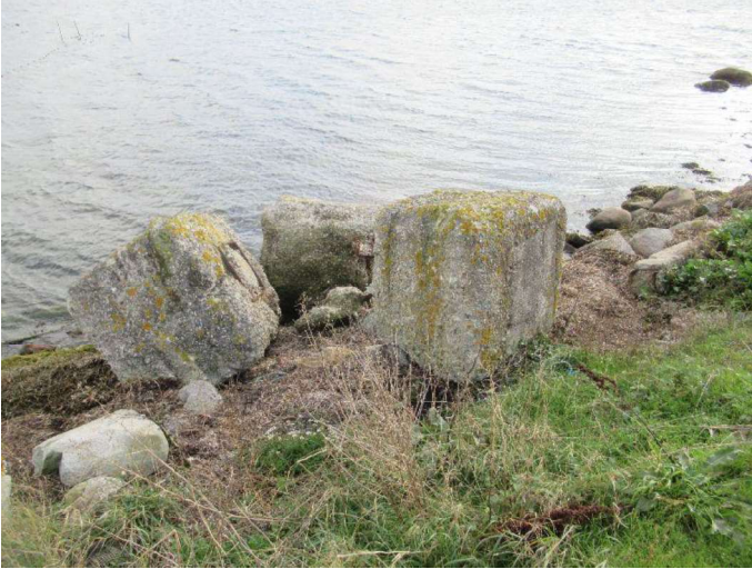
Skråning øst - Oversigtsbillede 3
