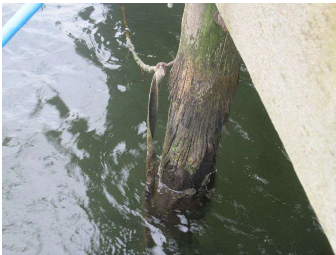
Bro 3 - Redningslinje Redningslinjen fremstår slidt og er knækket nogen steder.
