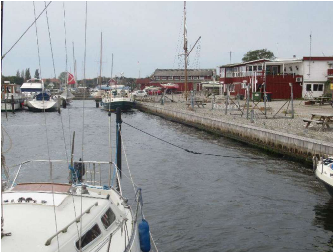
Kajstrækning øst - Oversigtsbillede
