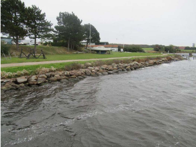
Skråning øst - Oversigtsbillede
