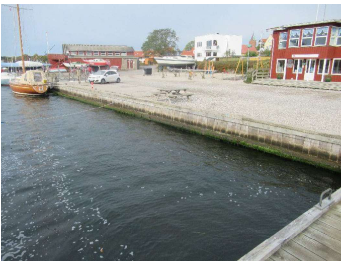
Kajstrækning øst - Oversigtsbillede 2
